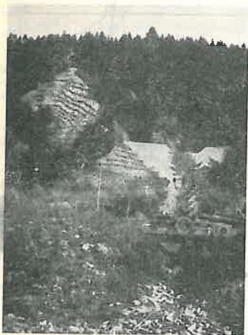
Fig. 1. Lucrări de artă — retenție și evacuare, lucrări de consolidarea malurilor — gardulețe — și plantații cu salcie pe depunerile conului de dejecție al piriului Virleanu, în perimetrul Galu (foto: V. Voinea).
