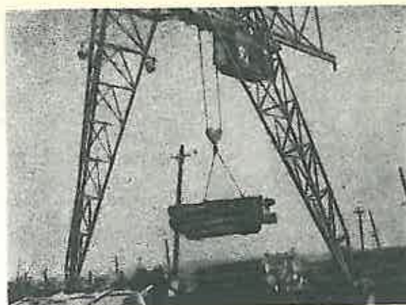
Fig. 4. Încărcarea lemnului rotund în vagoane C.F.R. cu macaraua capră.
