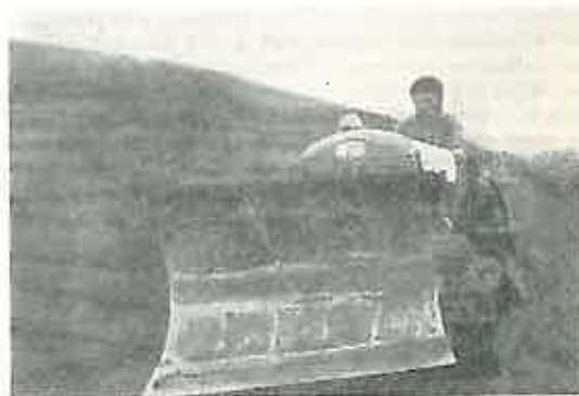
Fig. 3. Tractor cu lama de buldozer conceput de Stațiunea din Mátrafüred, lucrînd la terasare (foto: V. Bakos).
