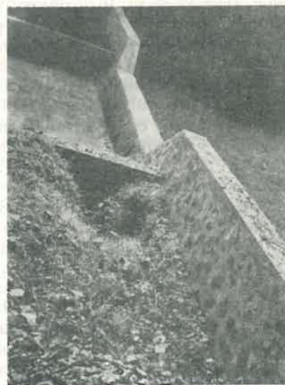
Fig. 6. Piesa 3.M.1.0. Se observă efectul eroziunii produse în spatele zidurilor de conducere de apele care au deversat peste întreaga lucrare. Pe aripile pragului și pe zidurile de conducere s-au depus materiale o dată cu scăderea nivelului apelor de viitură.
