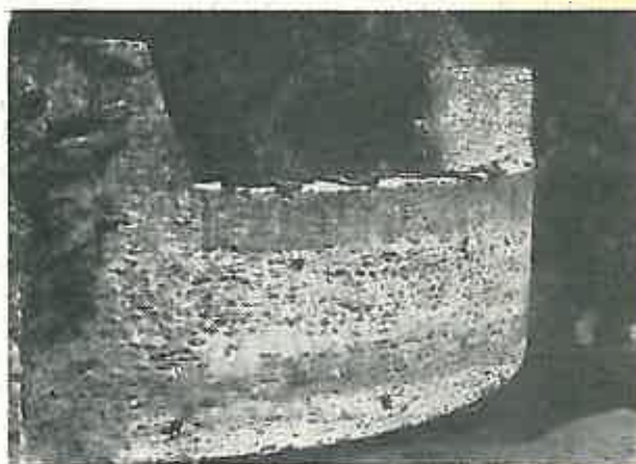
Fig. 4. Baraj în arc, pe torentul Grotu Lotru, după trecerea viiturii. Foto: R. Gaspar.
