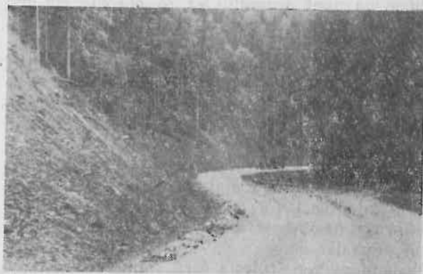
Fig. 2. Drumul auto-Korimovo. Porțiune în curs de finisare; se observă calitatea foarte bună a imbrăcăminții, ca urmare a execuției îngrijite.
