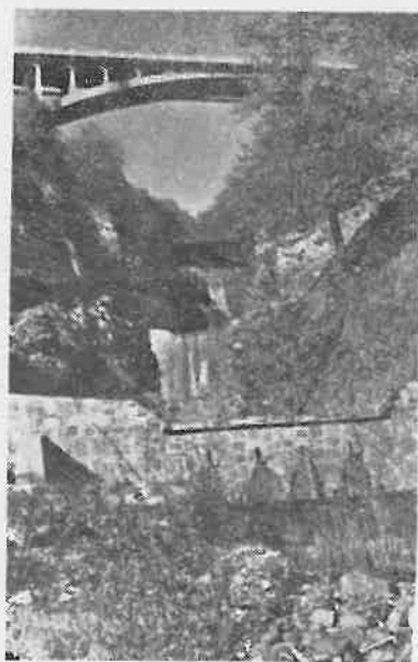
Fig. 4. Baraje executate în perimetrul Valea Orașilor, pe Valea Prahovei, D. S. Ploești.
