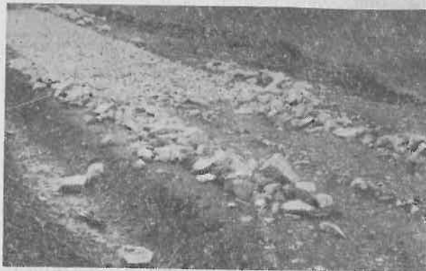
Fig. 1. Construcția suprastructurii drumului Korimovo. Se observă piatră de dimensiuni mari care se așază pe marginile fundației.
