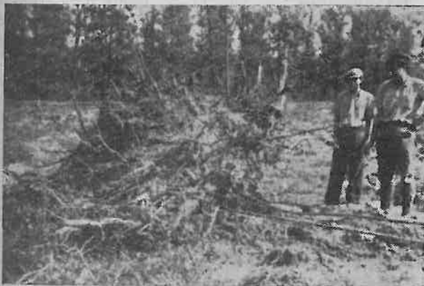
Fig. 3 — Deșrădăcinarea buturugii (Fotografie executată în faza a IV-a a deșrădăcinării). Se vede cablul, care — fiind înfășurat în jurul cioatei — permite continuarea deșrădăcinării.
