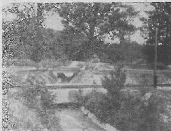
Fig. 2. Calea ferată și drumul național Pitești—Cîmpulung-Muscel, aparate în zona de interceptie cu torenții din perimetrul de ameliorare Băiculești — Mănicești, prin reglementarea scurgerilor cu ajutorul canalelor de evacuare a apelor
