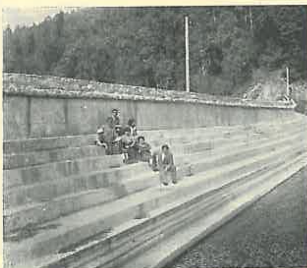
Fig. 12. Suprafața digului din spre apă, betonată în 1935.
