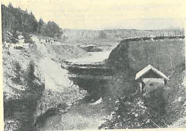
Fig. 11. Ruptura digului, văzută din aval.
