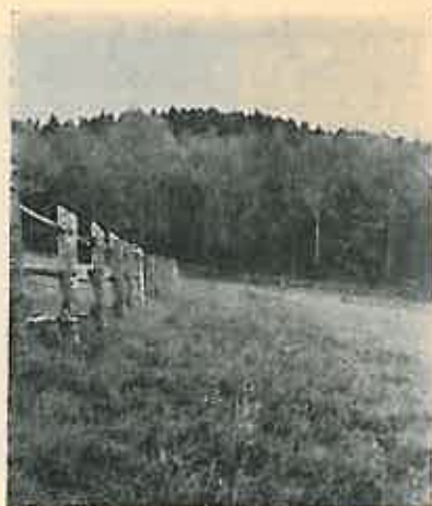
Fig. 8. — Oc. silv. Anina. În vederea zăpezilor înalte, gardul de lemn contra cerbilor are înălțimea de 1.80 m.
