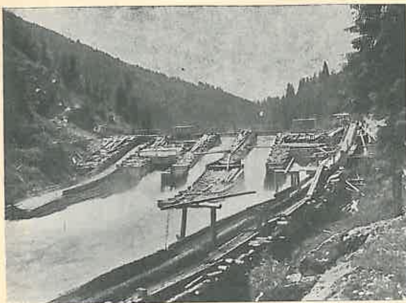
Opustul dela Vidra pe Lotru, văzut din avai.
